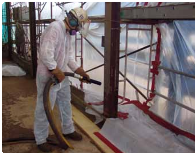
Sponge-Jet bei der Entrostung von Stahlträgern
