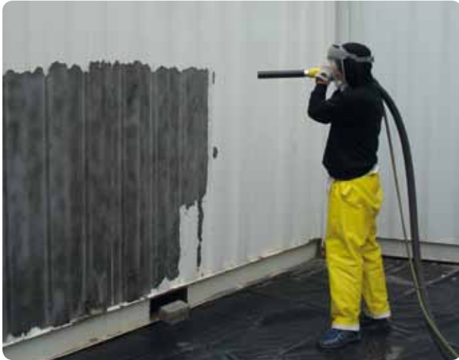
Sponge-Jet bei der Entrostung und Entlackung eines Containers
